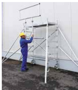
Перед подъемом на первую платформу дополнительная рама легко устанавливается с земли.
