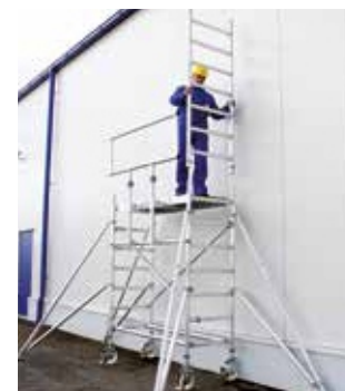
Защищенная «ведущими перилами», платформа, теперь можно безопасно войти в нее и продолжить дальнейшее строительство лесов. Перед тем, как перейти на следующий уровень, монтажное ограждение вставляется «вперед» для следующих платформ.
